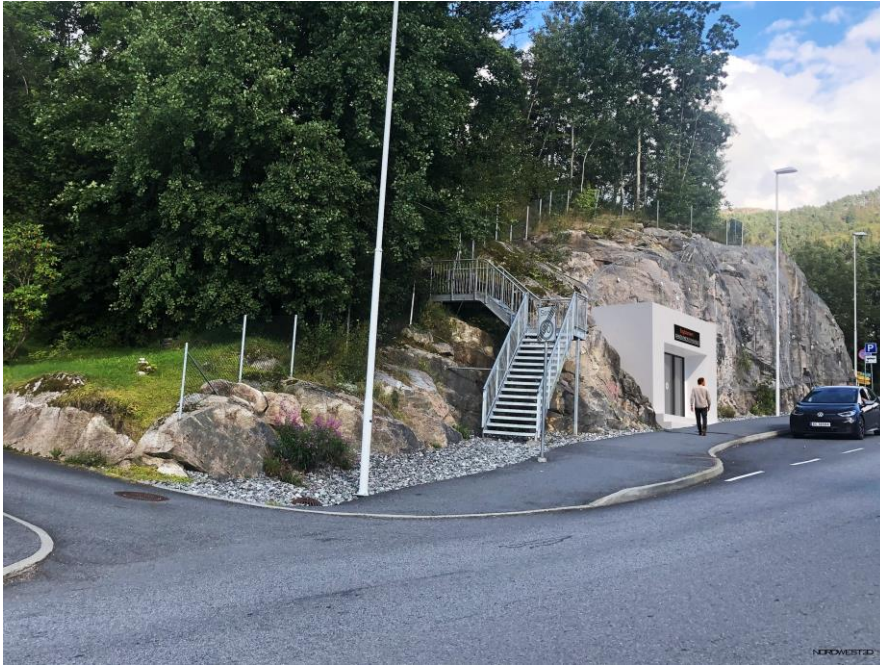
Holdeplass Sandviken Sykehus. Utgang Nyhavnsveien
