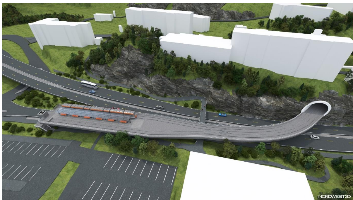
Ill. 11. Tunnelutløp og stasjonsområde ved NHH.
